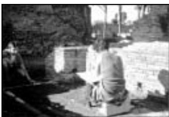
a) verformungsgerechtes Handaufmaß mit Zollstock
