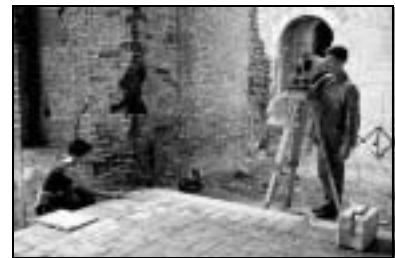
Abb. 5.8: Tachymetrische Bauaufnahme mit Reflektor
