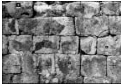
a) Quadermauerwerk, Akören II, Nordkirche, Messbild Rolle 6006, Ausschnitt
