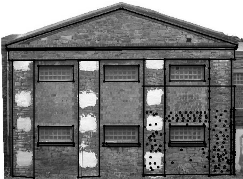
Abb. 5-22: Überlagerung eines entzerrten Photos mit Fassadenaufmaß und geplantem Element (rechts)
