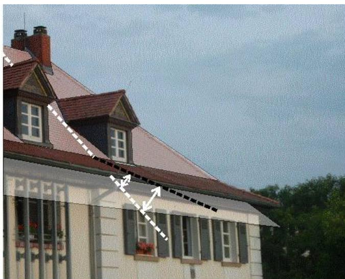
Abb. 38: Foto eines Daches mit „gekrümmt auslaufendem“ Rand
