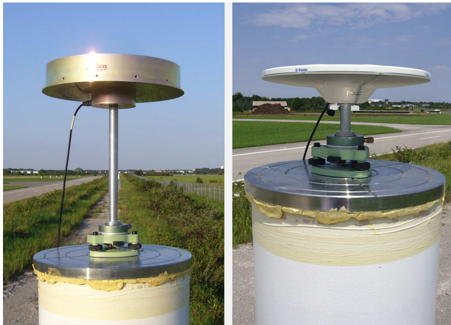
Abb. 11.11: Pfeiler und Antennenmontierung.
