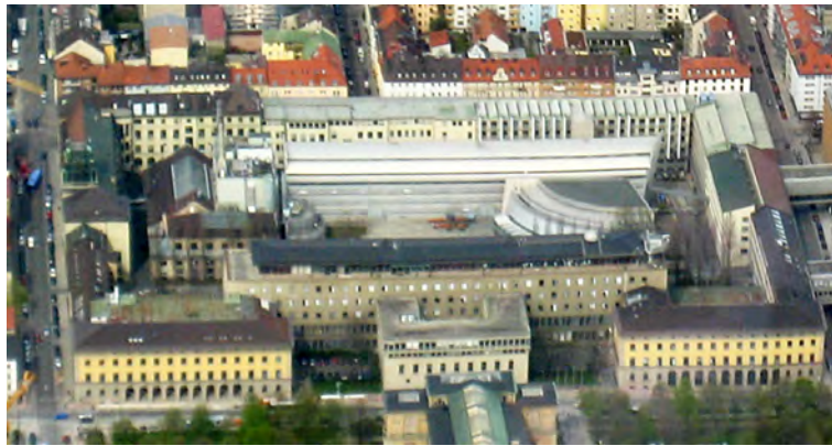
Abbildung 6.10: Schrägluftbild mit Blick auf die Ostfassade
