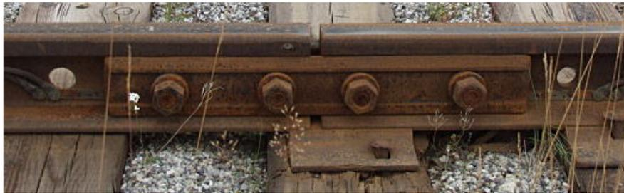
Abbildung 2.11: Durch Laschen verbundene Schienen (Reinmuth, 2013).
