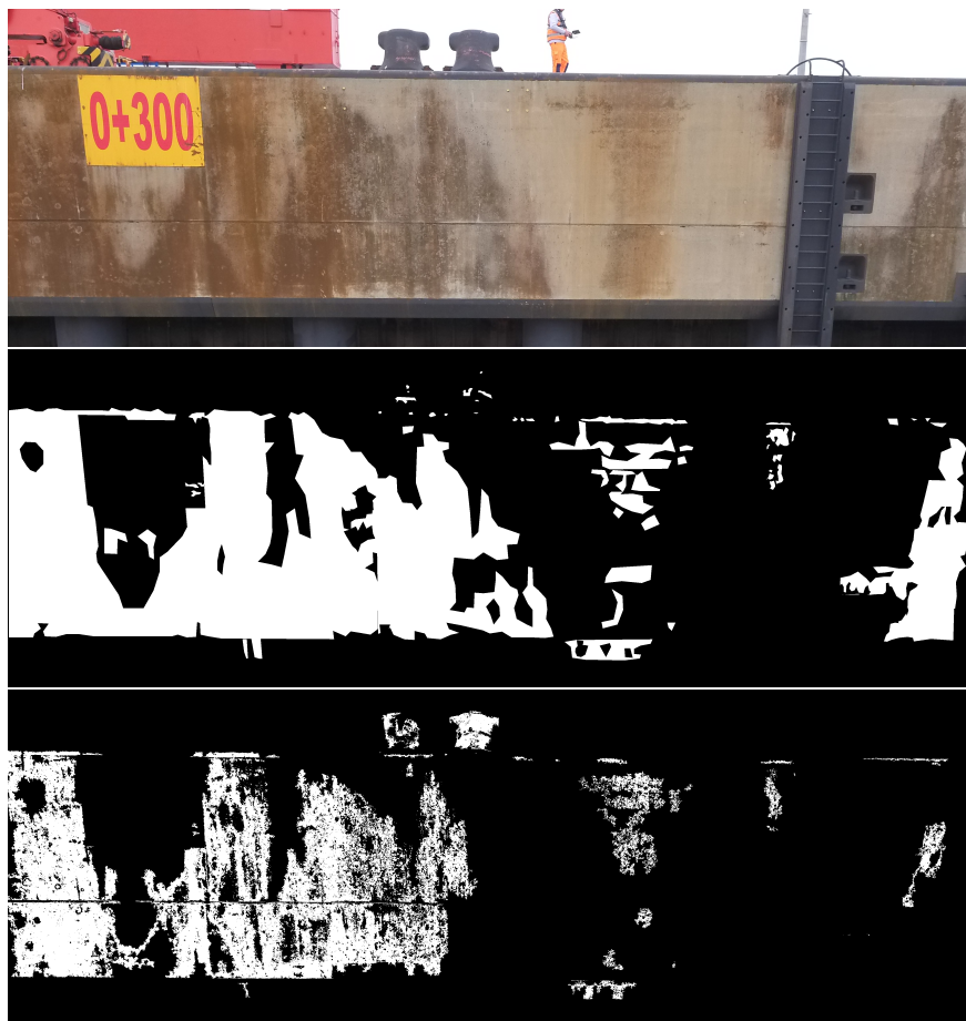
Abbildung 2.5: Beispielbild des JadeWeserPorts, oben das originale Farbbild, in der Mitte die manuell erzeugten Label und unten die Label vom schwach überwachten Region Growing Verfahren (Scherff et al., 2023).
