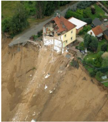
a) Eingebrochenes Tagebauufer am Concordiasee [GRAHN 2009]
