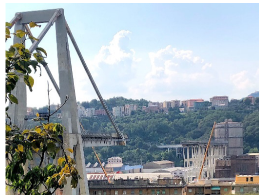
e) Polcevera-Viadukt nach dem Kollaps [FERRARIS 2018]
